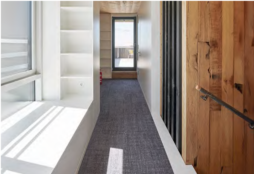
Abb. 03: Innenausbau mit gebrauchten Messebaumaterialien [Foto: © Olaf Mahlstedt]
