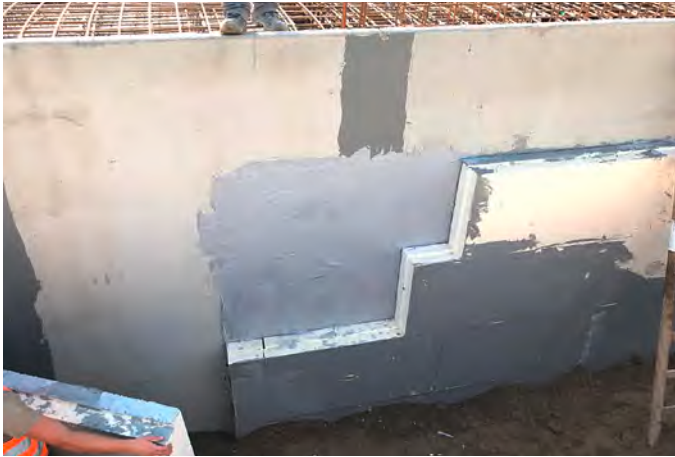
Abb. 05: Ansetzen einer rückseitig mit Klebermasse versehenen Dämmplatte
