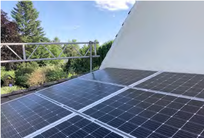
Abb. 04: Verschattete PV-Module
