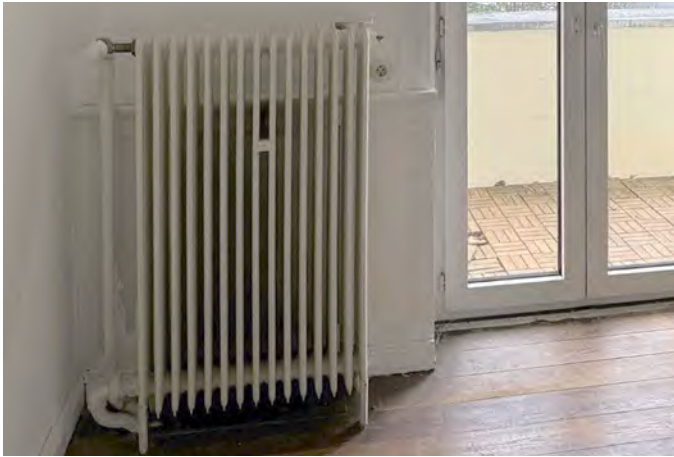
Abb. 03: Bestehender Heizkörper (Gussradiator)
