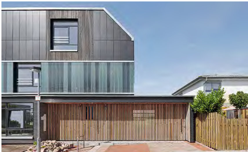
Abb. 02: Fassade aus gebrauchten Bauteilen [Foto: © Olaf Mahlstedt]
