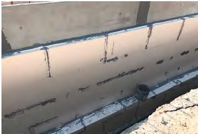
Abb. 06: Neu hergestellte, vollflächige Verklebung der Perimeterdämmung
