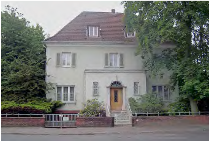
Abb. 01: Das Einfamilienhaus im unsanierten Zustand
