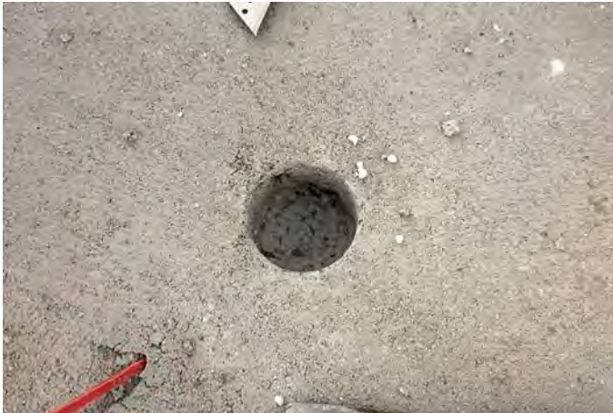
Abb. 04: Bohrung im Fußbodenaufbau für Probenahme
