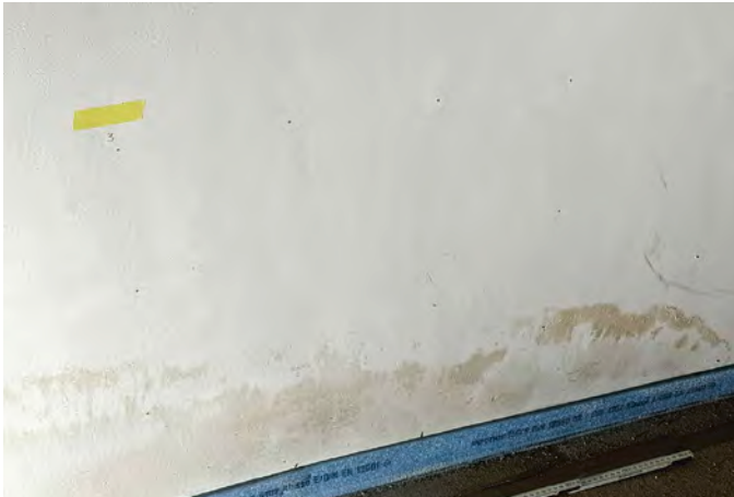
Abb. 08: Kellerwand mit Messpunkten für die Feuchtemessung
