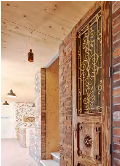
Abb. 04: Innenwände aus Abbruchziegeln [Foto: © Olaf Mahlstedt]
