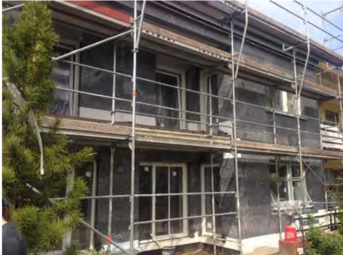
Abb. 02: Energetische Sanierung des Musterhauses [Foto: IFB]
