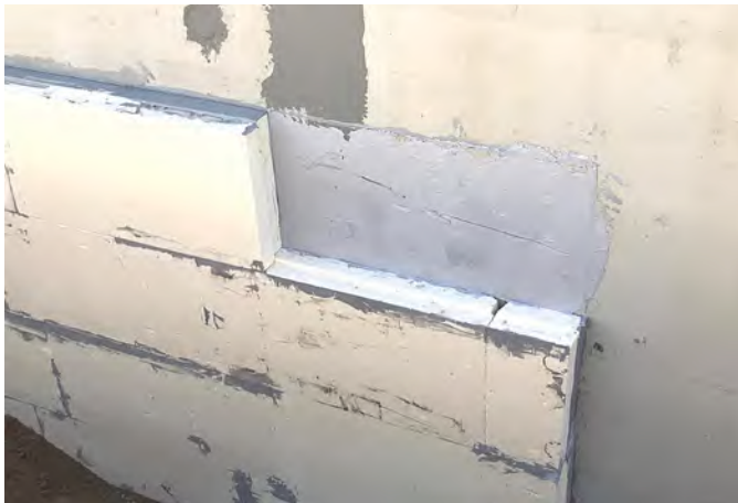
Abb. 04: Vollflächig aufgebrachte Klebermasse auf der Kelleraußenwand
