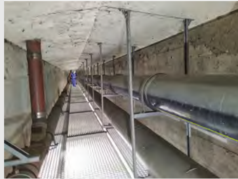
Abb. 04: Wasserleitung DN 200 und Gasleitung DN 300 werden auf Beschädigungen bzw. den Zustand der Rohraufleger geprüft. [Foto: Netze BW GmbH]
