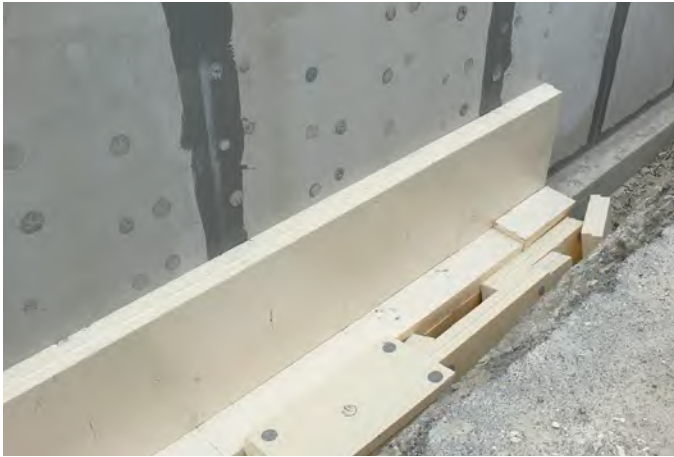
Abb. 02: Punktweise verklebte Perimeterdämmung
