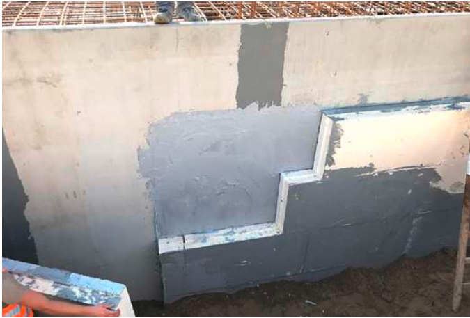
Abb. 05: Ansetzen einer rückseitig mit Klebermasse versehenen Dämmplatte
