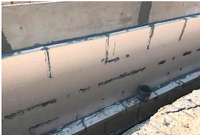
Abb. 06: Neu hergestellte, vollflächige Verklebung der Perimeterdämmung
