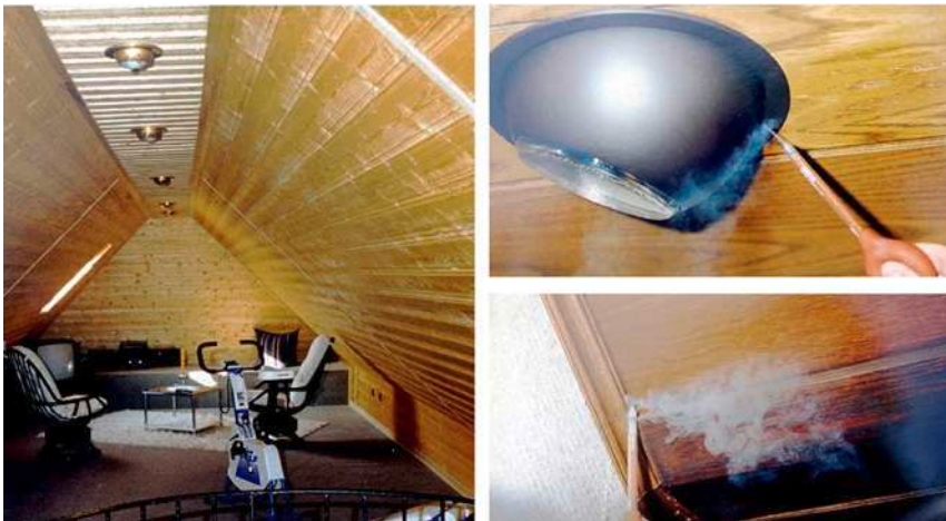
Abb. 13: Undichtheiten sind ungeeignet, bestimmungsgemäß in den Räumen Feuchtigkeit abzuführen [Foto: Studie zum Lüften im Wohnungsbau]
