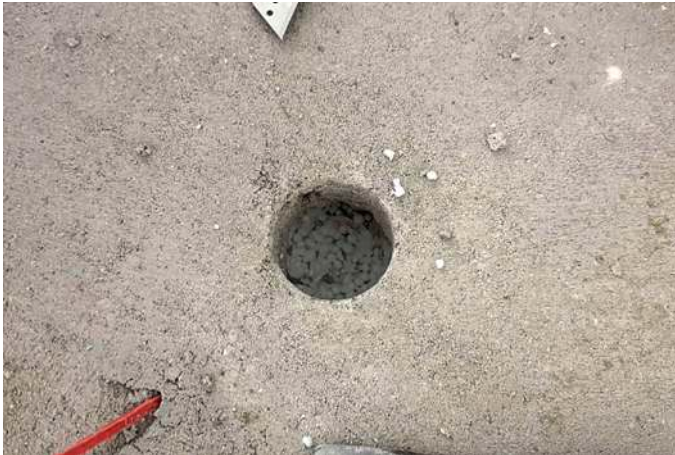
Abb. 04: Bohrung im Fußbodenaufbau für Probenahme
