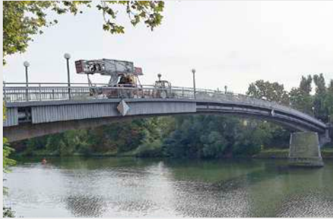
Abb. 02: Mithilfe eines Brückenuntersichtgeräts wurden die Gasleitungen (2x DN 400) auf ihren Zustand geprüft. Hierfür wurde die Blechverkleidung an mehreren Stellen demontiert. Im Zuge dieser Prüfung konnten die Auflager und Rohrteile einer Sichtprüfung unterzogen werden. [Foto: Netze BW GmbH]
