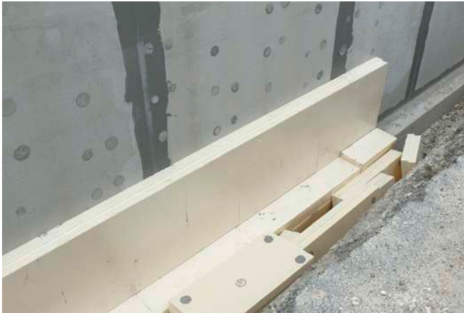
Abb. 02: Punktweise verklebte Perimeterdämmung
