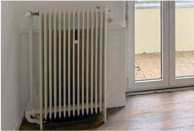
Abb. 03: Bestehender Heizkörper (Gussradiator)
