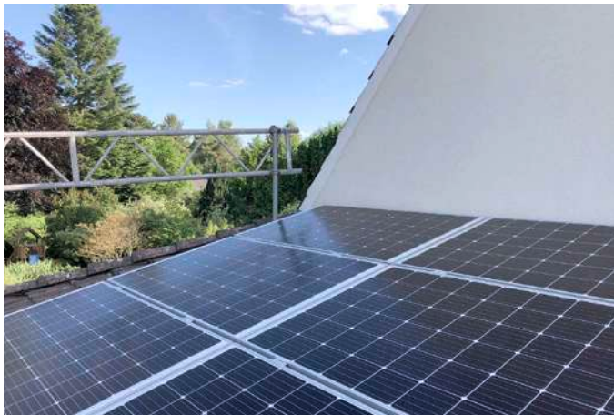
Abb. 04: Verschattete PV-Module
