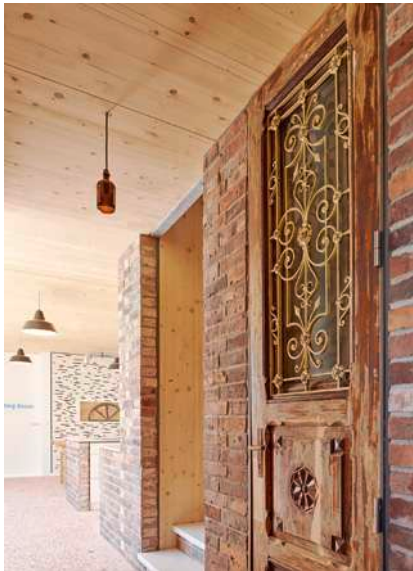
Abb. 04: Innenwände aus Abbruchziegeln [Foto: © Olaf Mahlstedt]
