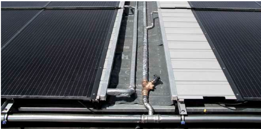
Abb. 03: Hydraulische Anbindung der Wärmeübertragungsfelder (Wartungsgang wird durch PV-Modul verdeckt) [Foto: nD-System GmbH]
