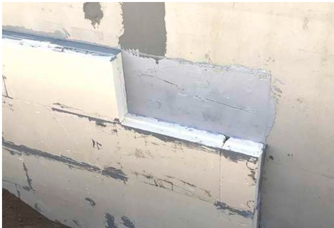
Abb. 04: Vollflächig aufgebrachte Klebermasse auf der Kelleraußenwand
