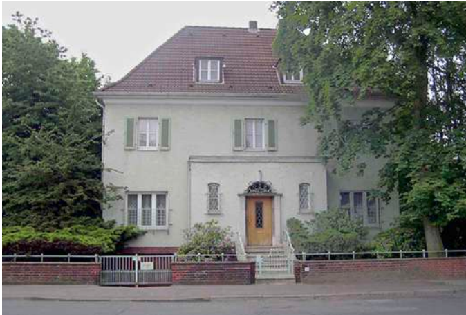
Abb. 01: Das Einfamilienhaus im unsanierten Zustand
