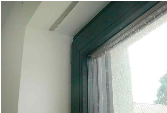
Abb. 01: Neu eingebautes Fenster mit Dreifachverglasung
