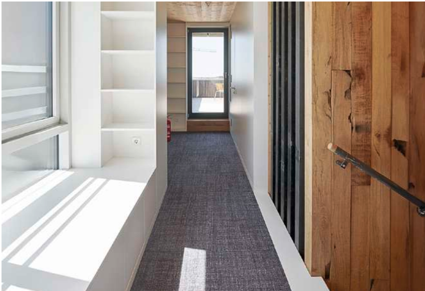
Abb. 03: Innenausbau mit gebrauchten Messebaumaterialien [Foto: © Olaf Mahlstedt]
