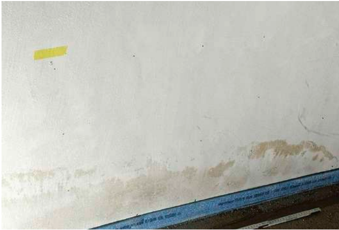
Abb. 08: Kellerwand mit Messpunkten für die Feuchtemessung
