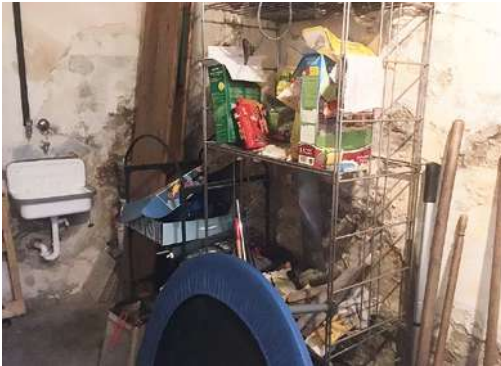
Abb. 04: Keller Außenwand mit großflächigen Feuchteverfleckungen, Wasserrändern und Putzabplatzungen
