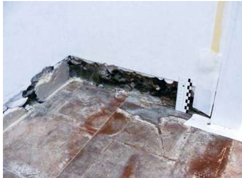
Abb. 04: Detailansicht des beschädigten Natursteinbelags im Treppenhaus
