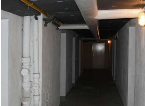
Abb. 01: Kellerdecke mit der nachträglich angebrachten Wärmedämmung
