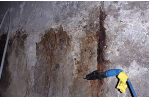
Abb. 06: Einspeisung / Tracer im Außenwandbereich [Quelle: Texplor GmbH]
