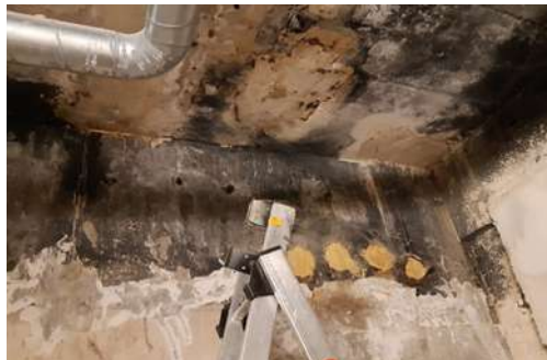
Abb. 05: Deckenbereich mit Feuchtigkeitsschäden [Quelle: Texplor GmbH]
