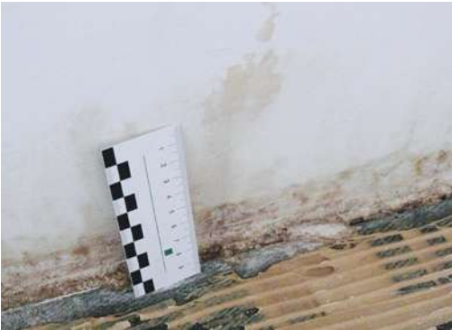
Abb. 03: Detailansicht des beschädigten Innenputzes in einem Wohnraum
