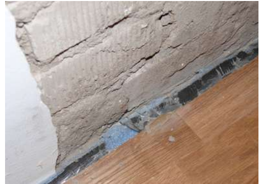
Abb. 06: Teilweise entfernter Innenputz in einem Wohnraum
