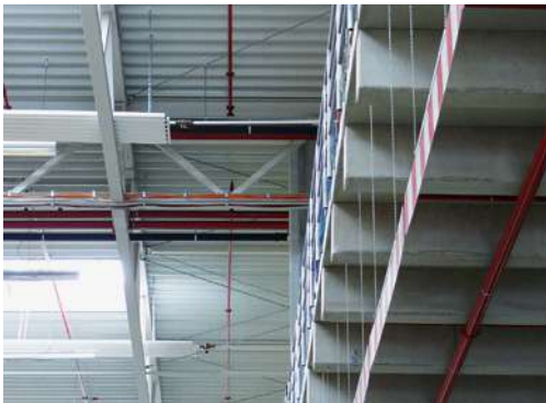
Abb. 03: Blick unter das Hallendach mit den neu verlegten Kabeln mit Funktionserhalt
