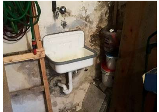
Abb. 05: Teilansicht der feuchtegeschädigten Keller Außenwand aus Abb. 04
