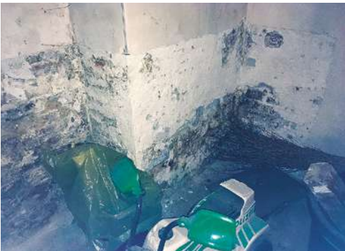
Abb. 02: Kelleraußenwand mit Farb- und Putzabplatzungen
