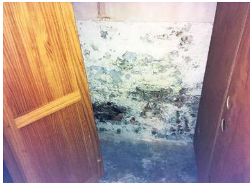
Abb. 03: Kelleraußenwand mit Putzabplatzungen und Salzausblühungen
