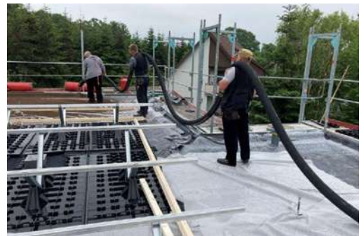
Abb. 02: Das Substrat für die extensive Begrünung wird per Druckluft auf die Dachfläche geblasen.
