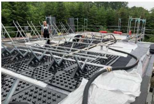
Abb. 01: Die Montageprofile für die PV-Module sind auf den Grundplatten montiert und müssen mit der erforderlichen Schütthöhe des Substrats laut der statischen Berechnung befüllt werden.
