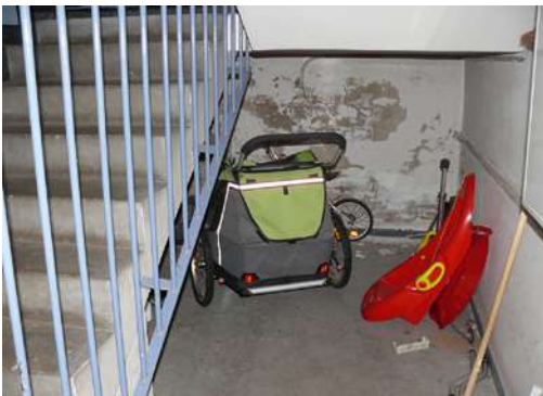
Abb. 06: Feuchtegeschädigte Keller Außenwand im Treppenhaus mit sichtbaren Farbabplatzungen
