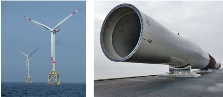
Abb. 01: Links – Offshore Windenergieanlage mit Jacket-Gründungsstruktur aus dem Windpark alpha ventus [Foto: Institut für Stahlbau, LUH]; rechts – Monopile bei Steelwind, Nordenham [Foto: Peter Schaumann]
