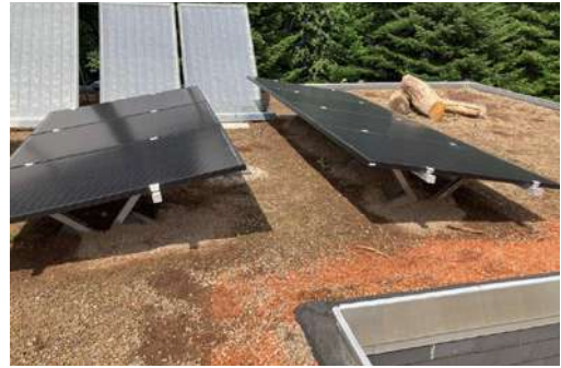
Abb. 04: Das multifunktionale Dach mit der Photovoltaik- und der Solarthermieanlage auf der Dachbegrünung ist fertig. Auf der Dachbegrünung wurde für mehr Biodiversität Totholz ausgelegt.
