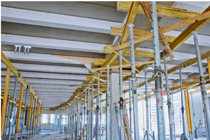
Abb. 02: Vorgefertigte Holz-Hybriddecke mit oberflächennaher Bauteilaktivierung und Reduktion des CO 2 -Footprints um 60 Prozent
