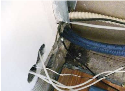
Abb. 05: Detailansicht des beschädigten Innenputzes in einem Wohnraum, teilweise entfernter Bodenbelag
