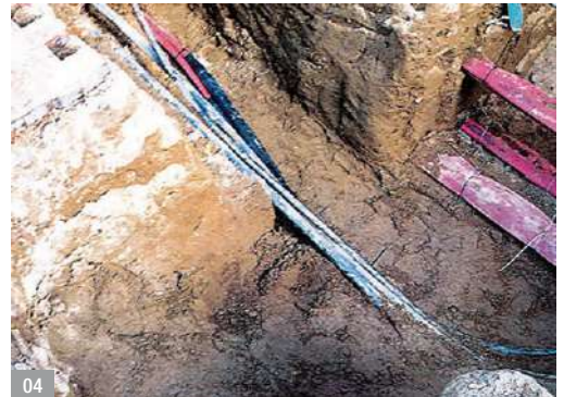
Abb. 04: Reparierte Kabeltrasse, neues Teilstück mit Schrumpfmuffe
