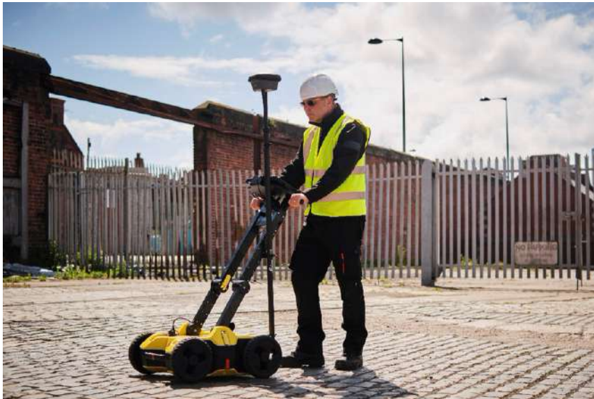
Abb. 02: Leitungsortung durch Bodenradar [Quelle: Hexagon Geosystems]
