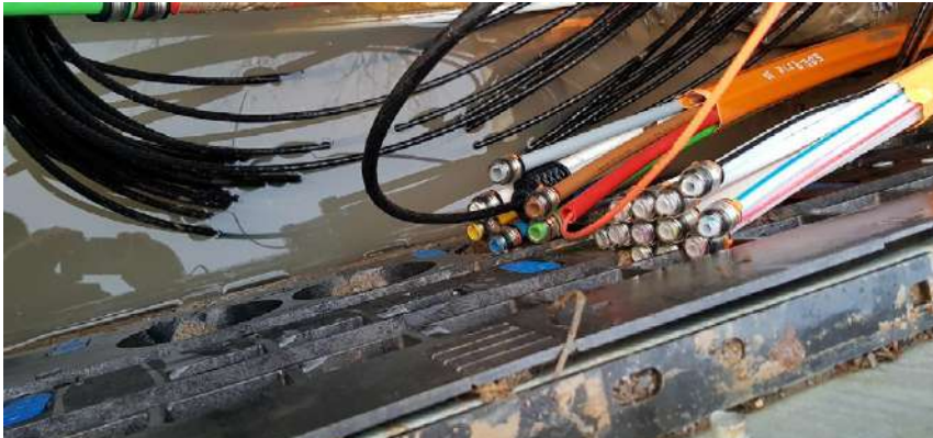
Abb. 03: Einblasen in Rohrbündel (Telekom-Anwendung) [Quelle: CHASE/NEPTCO]
