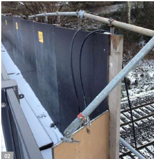
Abb. 02: Traggerüst: Seitliche Absturzsicherung
