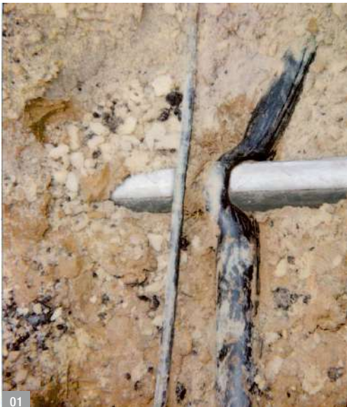
Abb. 01: Durchbohrtes Telekommunikationskabel
