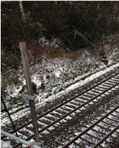
Abb. 05: Umgeknickter Oberleitungsmast
