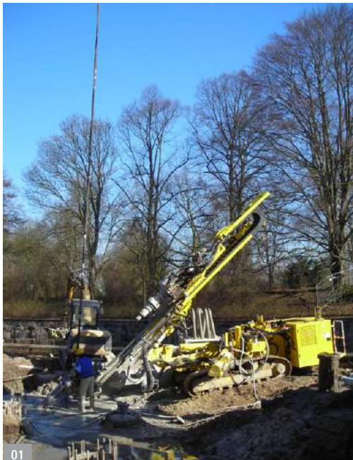
Abb. 01: Doppelkopfbohranlage mit Überlagerungsbohrsystem (Symbolbild)
