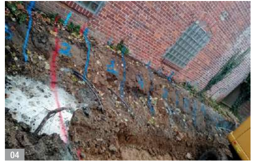
Abb. 04: Farbige markierte Unterfangungsabschnitte
