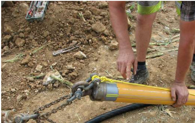
Abb. 02: Anwendung beim Einziehen (HDD-Verfahren) [Quelle: CHASE/NEPTCO]
