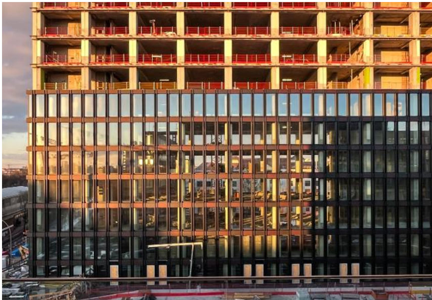
Abb. 04: Fassadenbaustelle [Foto: Konrad Hofmann]
