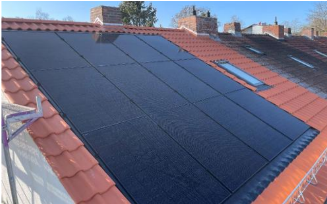
Abb. 05: Indach-Photovoltaikanlage auf dem denkmalgeschützten Dach [Foto: Holz- und Energiewerk GmbH]
