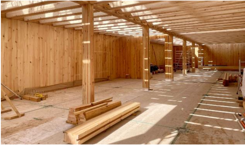
Abb. 05: Vorgefertigte Holz-Gebäudeabschlusswand mit sichtbaren Kiefernstielen im Innenbereich
