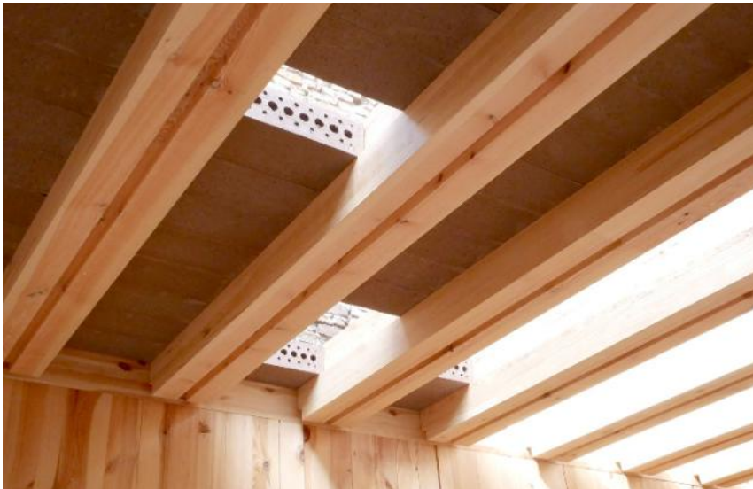
Abb. 04: Holz-Lehm-Hybriddecke mit tragenden Holzbalken und eingehängten Lehmformsteinen
