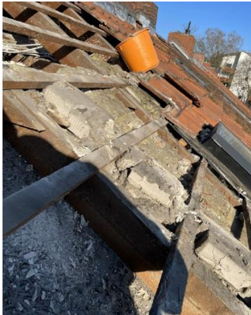
Abb. 01: Die Dachöffnung gibt den Blick auf die alten mit Mörtel verschmierten Dachziegel frei. [Foto: Holz- und Energiewerk GmbH]
