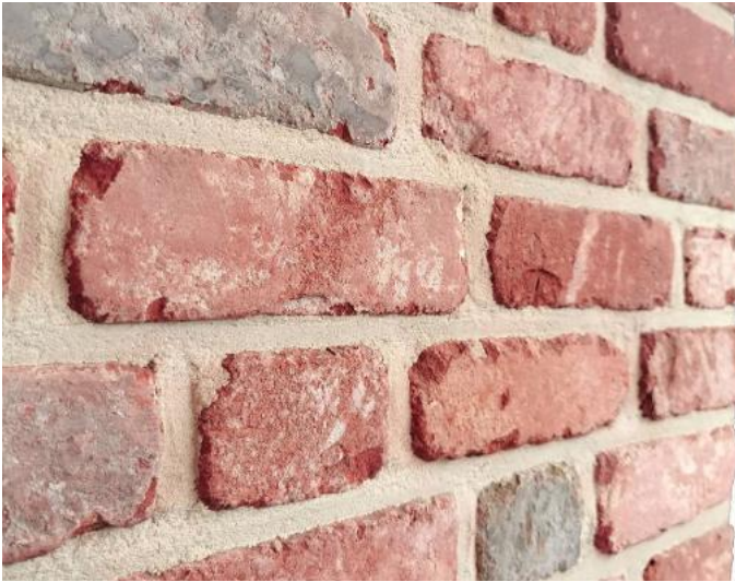
Abb. 04: Ziegelriemchen als dünne Verkleidungsschicht [Foto: L. Hildebrand]
