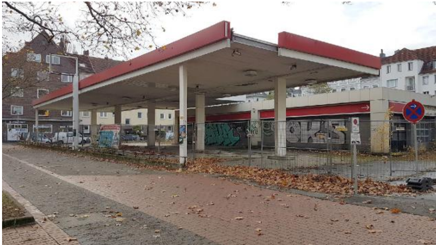
Abb. 03: Stillgelegte Tankstelle auf dem Grundstück des Neubaus der KSG-Firmenzentrale in Hannover [Foto: Wilhelm Wallbrecht GmbH & Co. KG]
