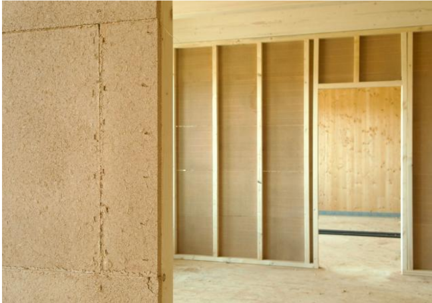
Abb. 02: Lehm-Trockenbau im Rohbau [ClayTec GmbH & Co. KG]
